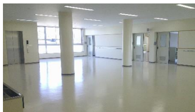
二階廊下・ロビー
